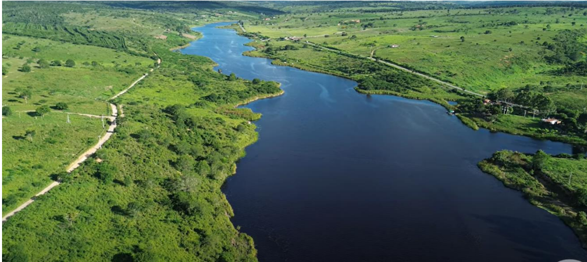
Figura 8 - – Ilustração da barragem de Morrinhos no corredor da LT 230 kV Poções III – Itabuna III C1 e C2 (CD). Fonte: https://www.youtube.com/watch?v=TNQgkO8miFw
